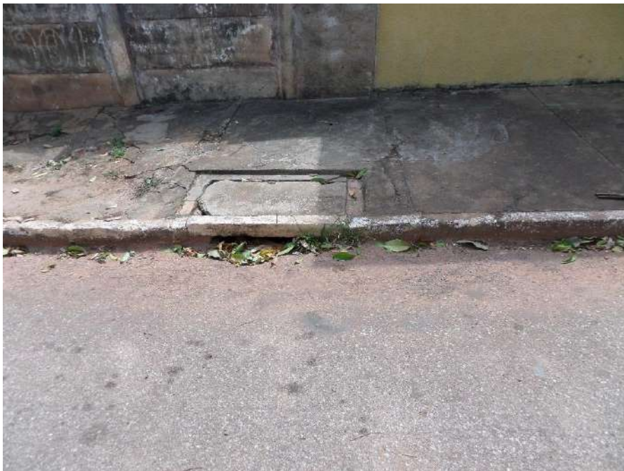
Figura 32: Boca de lobo na Av. Sen. Antônio R. Caiado.
