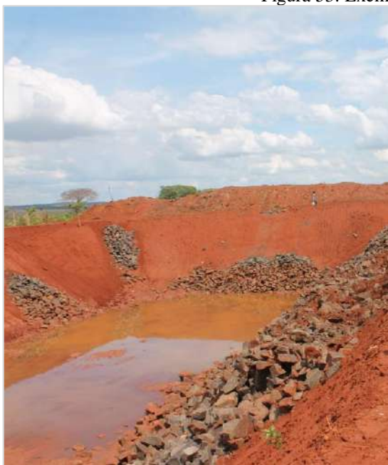
Figura 53: Exemplos de reservatório de drenagem
