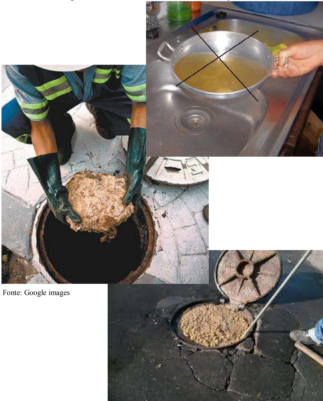
Figura 69: Descarte indevido de óleo ocasiona obstrução na rede
