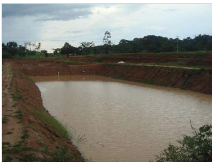
Figura 53: Exemplos de reservatório de drenagem
