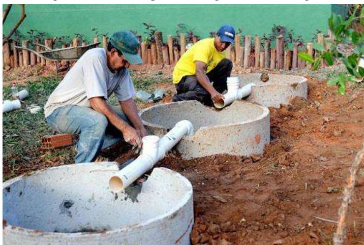
Figura 44: Fossas sépticas biodigestoras - montagem
