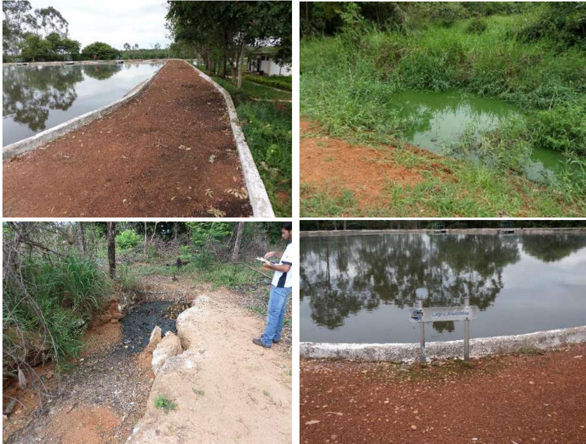
Figura 28: Irregularidade na ETE Araguapaz
