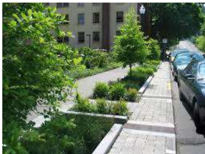
Figura 58: Vala de infiltração vegetada
