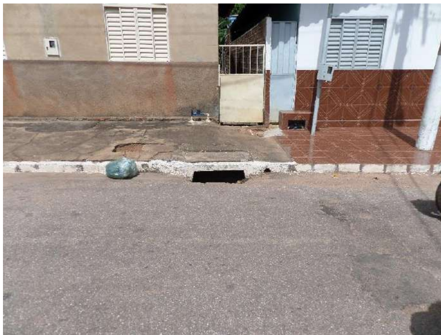
Figura 33: Boca de Lobo na Avenida Tiradentes
